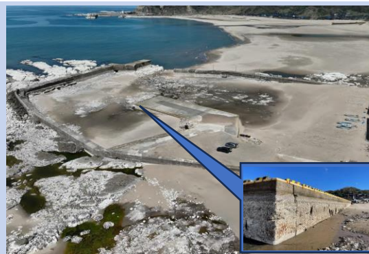
漁港施設（輪島市黒島漁港）
