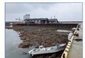
漁港の被害（海底地盤隆起）、漁船の座礁
