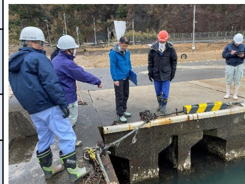
MAFF-SATによる被災状況調査
