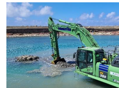
水陸両用バックホウによる赤神漁港の仮復旧工事
