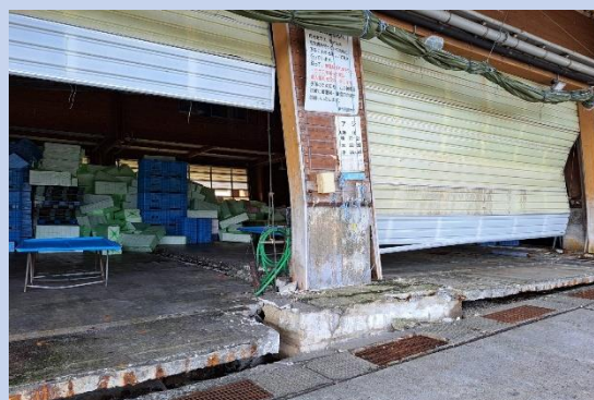
共同利用施設（輪島市輪島港）
