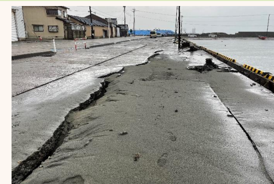
漁港施設（富山県射水市新湊漁港）
