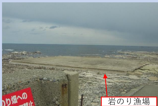
漁業用施設（北部珠洲地区）
