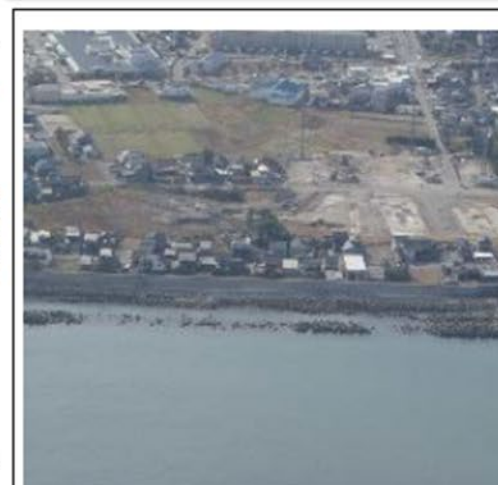
離岸堤の劣化の例
