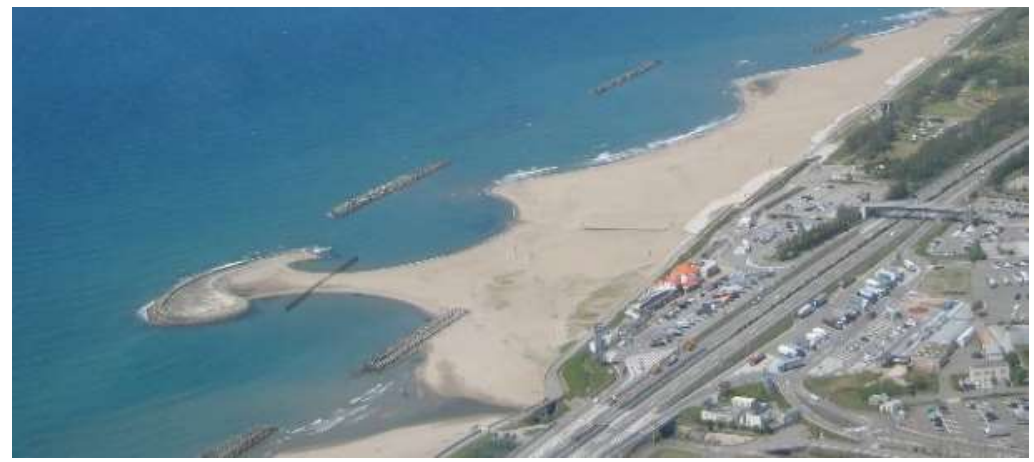
侵食対策として整備した、石川海岸 (松任工区) の砂浜を海岸保全施設として指定 (海岸法に基づく指定としては初の事例)
