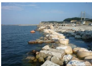
地震により岸壁が倒壊
