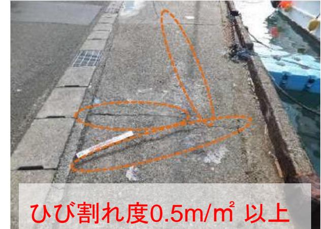
同じひび割れでも、施設種類や構造形式で老朽化度b以上の判定基準が異なる点に留意
