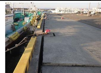
岸壁エプロン沈下、目地の開き
