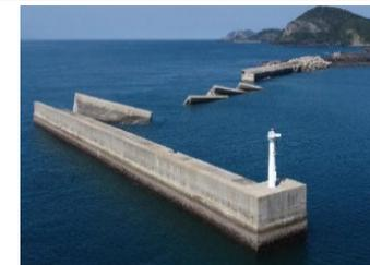
台風による防波堤の倒壊
