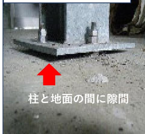
柱と地面の間に隙間
