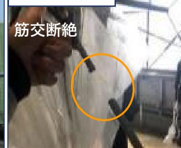
柱の接地面の隙間
