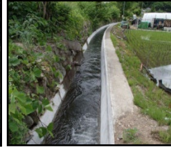
老朽化した用水路の整備・更新
