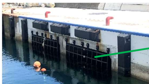
海水交換施設の整備
