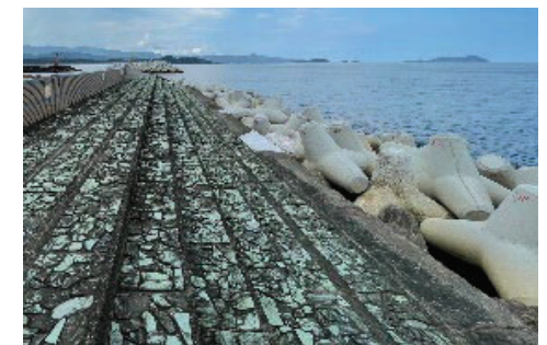
水域と接する漁港環境整備施設の例(護岸)
