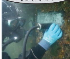
潜水による施設調査
