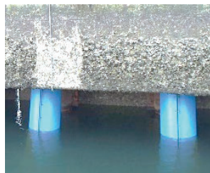
損傷が軽微な段階で予防的な修繕を実施
