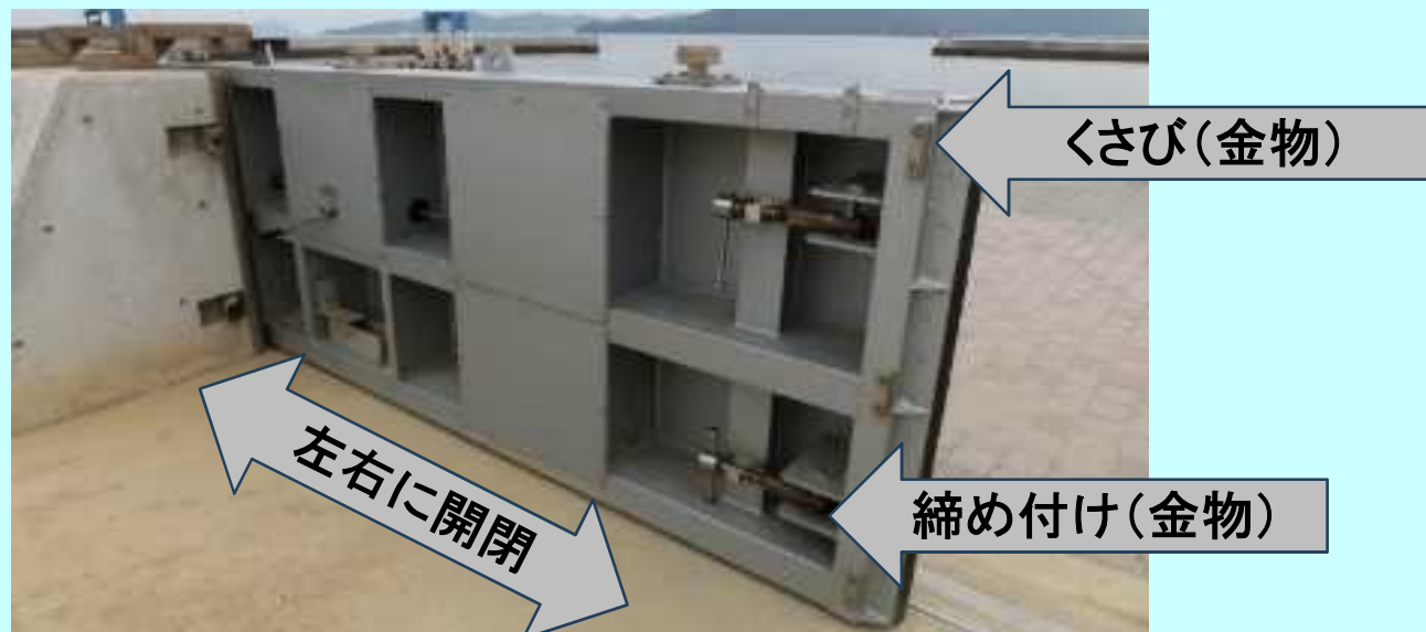
図-3 手動横引式小型陸閘
