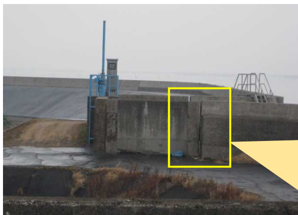
沈下による機能低下の例
