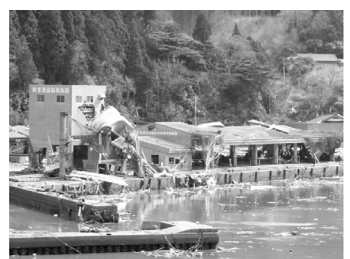
荷捌施設被災状況
