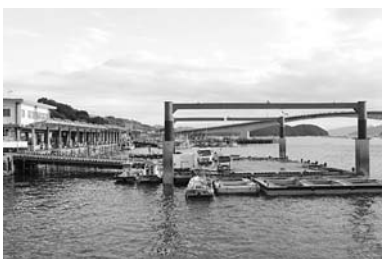
活魚ボンツーン(活魚生簀付き浮桟橋)
