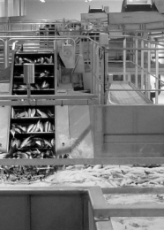
八戸漁港の施設
