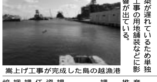
高上げ工事が完成した鳥の越漁港の様子
