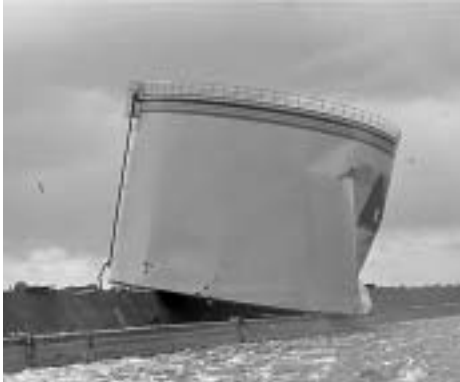
宮城県石巻漁港(給油タンクの被災)
